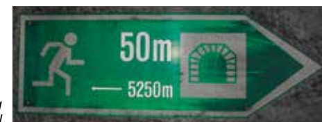
Fluchtwegebeschilderung im Adler-Bahntunnel
